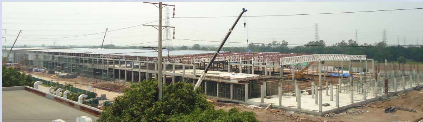
建設中のボールベアリング新工場(タイ バンパイン工場)
